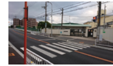
拡幅された歩道と横断歩道
